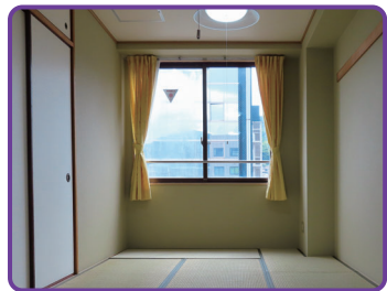
天井を新しくしました
